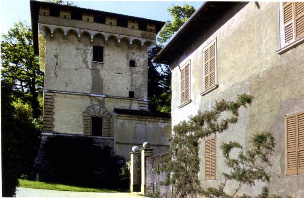
Dell'antico castello resta solo la poderosa torre a pianta quadrata (circa 10 metri per lato); quasi isolata e posizionata nell'angolo nord - occidentale del complesso (il punto più elevato), è caratterizzata dalla base scarpata e dal bugnato manierista che segna gli spigoli e la cornice delle finestre.
